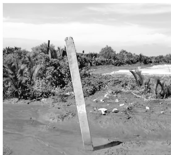
Hình 1. Đầu cọc chuyển vị 0.4m ngay sau khi đóng.
