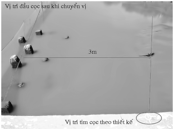
Hình 2. Đầu cọc chuyển vị khi mực nước hạ xuống theo thủy triều.
